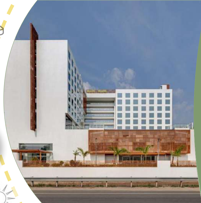
चित्र में भवन में छाया प्रदान करने के लिए इस्तेमाल किए गए जाली को दिखाया गया है
