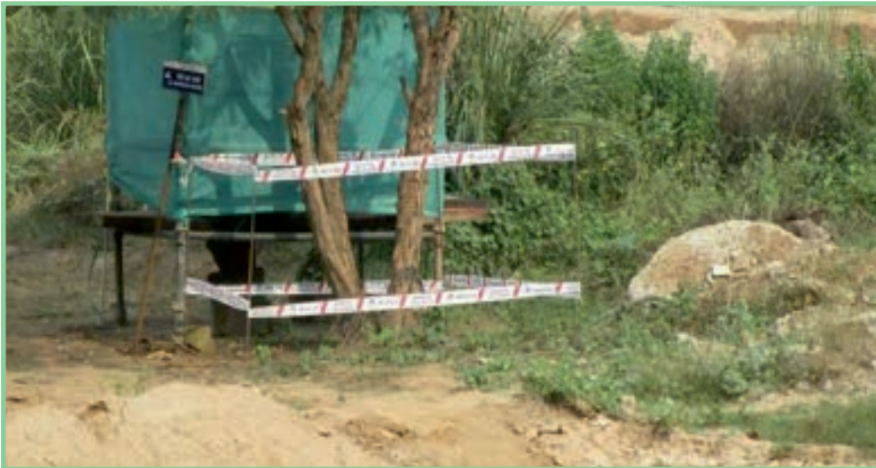
▲ സ്റ്റീൽ കമ്പികൾ, സുരക്ഷാ ടേപ്പുകൾ എന്നിവ ഉപയോഗിച്ച് ബാരിക്കേഡ് ചെയ്യുന്നതിന്റെ മാതൃക. | പ്രോജക്ട് സ്ഥലം: ബിജ്നോർ, ഉത്തർപ്രദേശ്
