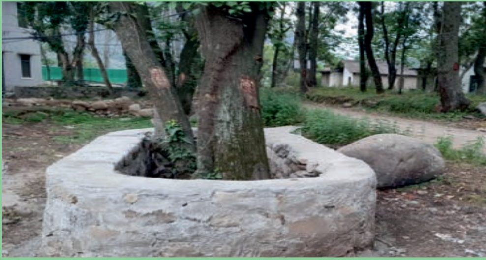
▲ കെട്ടിടങ്ങളുടെ അവശിഷ്ടങ്ങളായ കല്ലുകളും ചരലുകളും ഉപയോഗിച്ച് കെട്ടിയെടുത്ത സംരക്ഷണഭിത്തിയുടെ മാതൃക | പ്രോജക്ട് സ്ഥലം: ചമ്പ, H.P.
