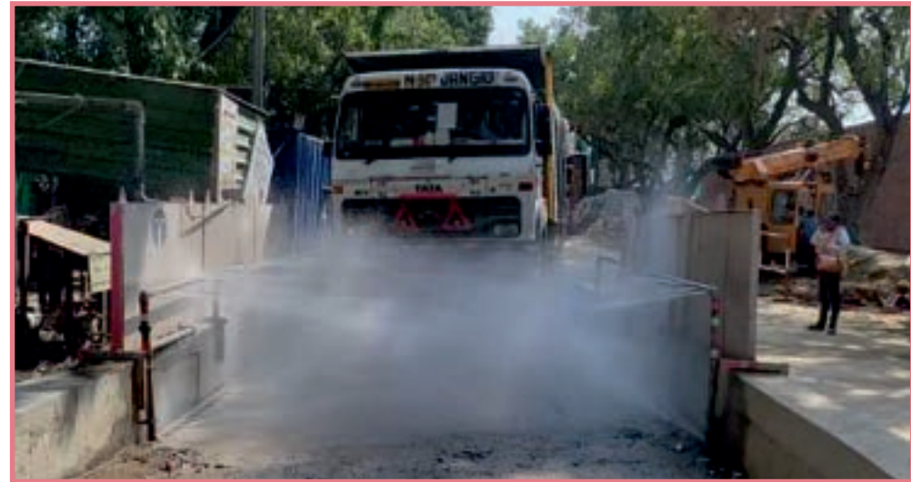
▲ മെക്കാനിക്കൽ വീൽ വാഷിംഗ് സൗകര്യം ഉപയോഗിച്ച് കഴുകുന്ന ഒരു ട്രക്കിന്റെ ടയറുകൾ പദ്ധതി സ്ഥലം: ന്യൂഡൽഹി
